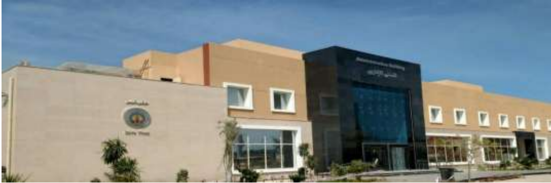
شكل (٤): صورة توضح الواجهة الرئيسية للمبنى الذي سيتم عمل دراسة تحليلية له باستخدام برنامج Design Builder
